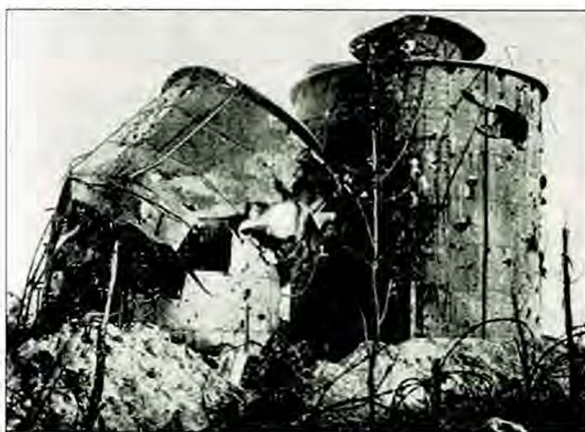
De uitgebrande petroleumtanks langs de IJzer in Diksmuide.
